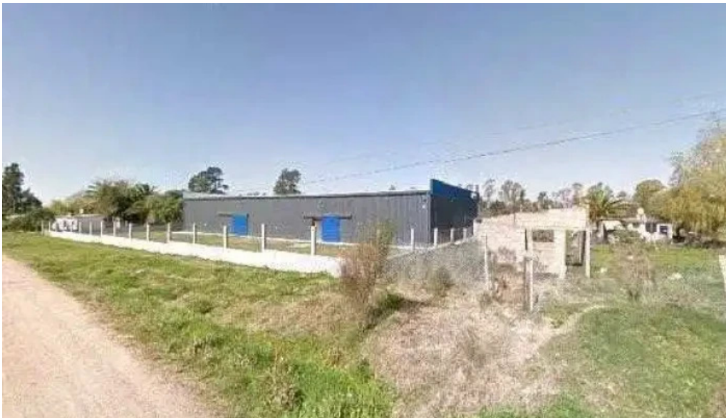
Igc electricidad electricidad
