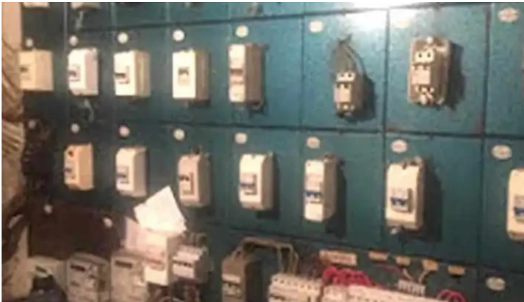
Fraga electricidad electricidad
