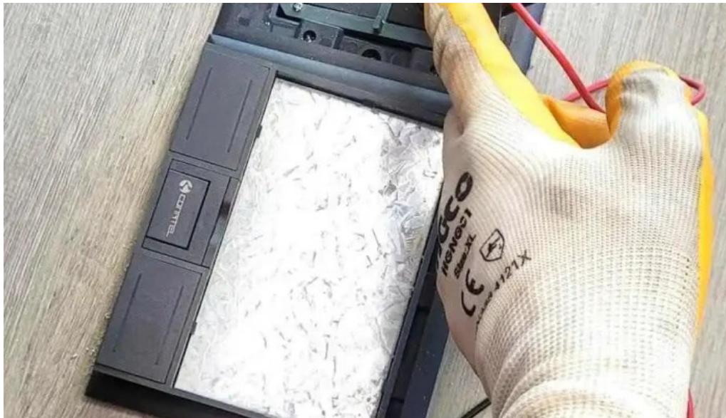
Electric service del propietario
