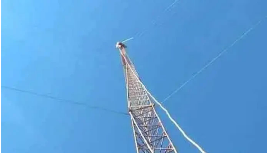
Adf electricidad cerro chato
