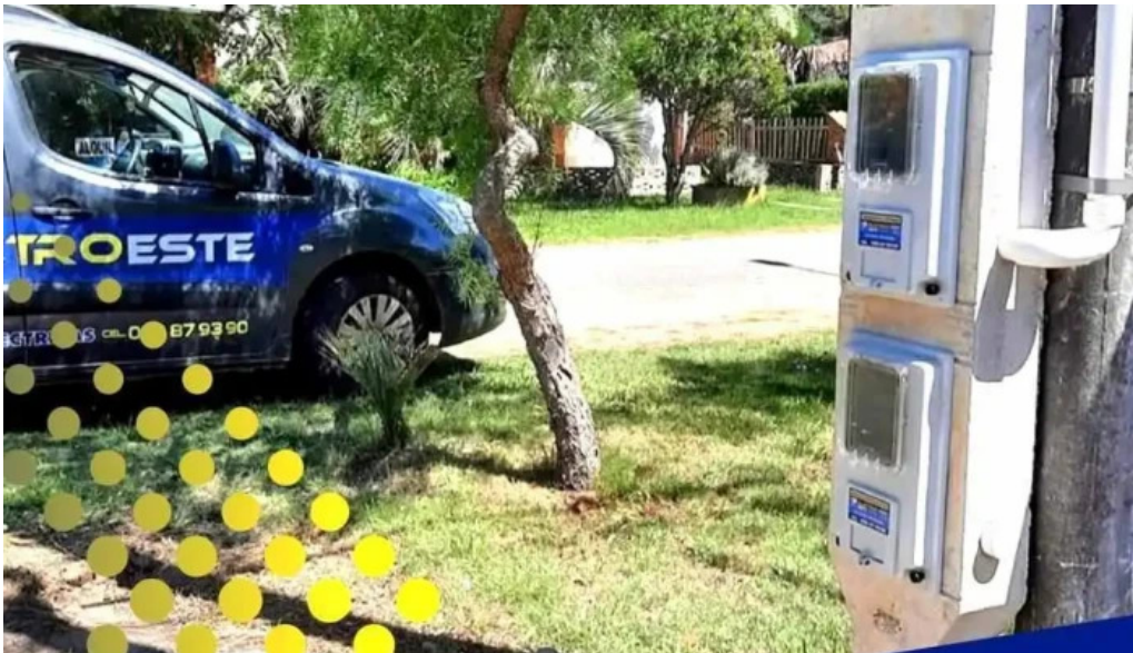
Electroeste de luis acosta instalaciones electricas en rocha y maldonado del propietario
