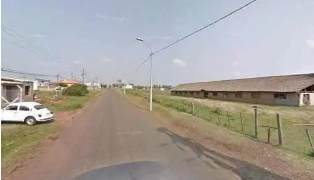
Serra electricidad electricidad
