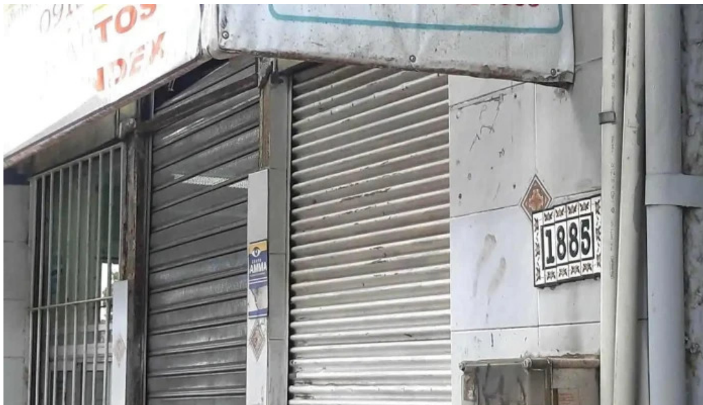
Cerrajería sosa exterior
