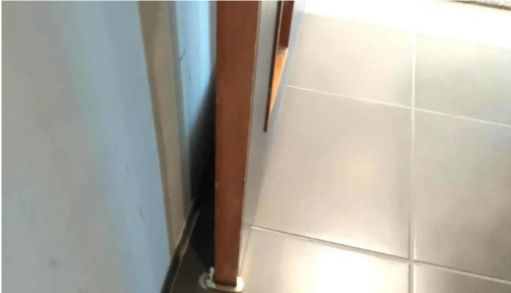
Cerrajería ale urgencias interior
