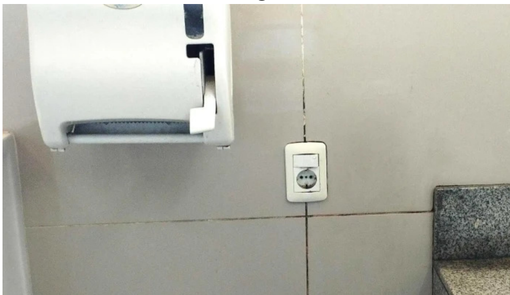
Terminal de omnibus ciudad de rocha zona
